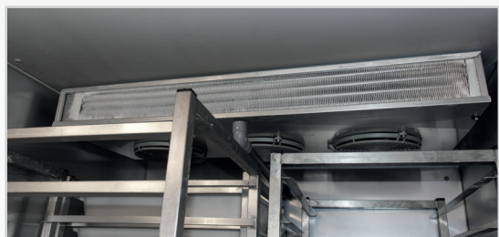
Évaporateur plafonnier sur-dimensionné à faible ventilation
